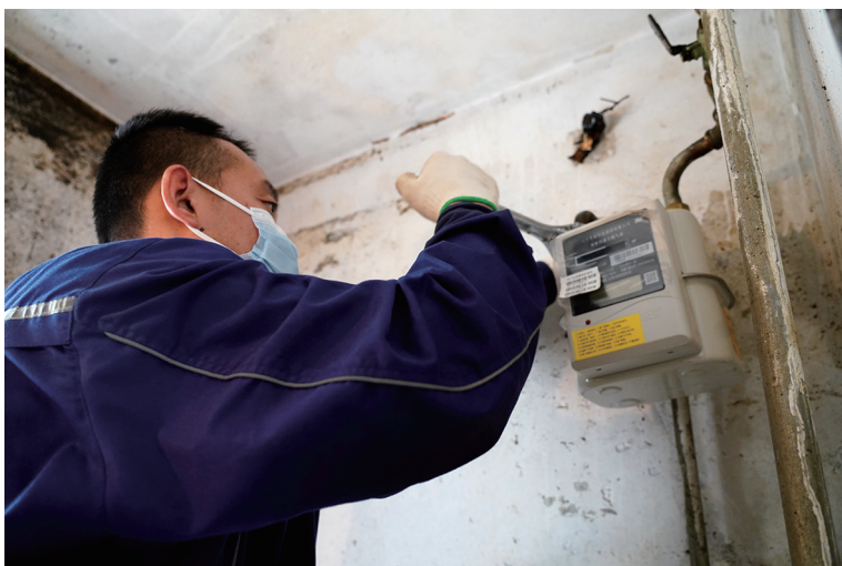
图为燃气维修人员正在更换新燃气表。 记者 魏伟 摄
