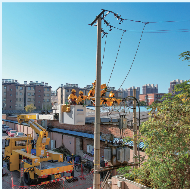
图为唐山公司配网带电作业人员在芳甸园小区对小区更换跌落式熔断器。(周宇翔 摄)
