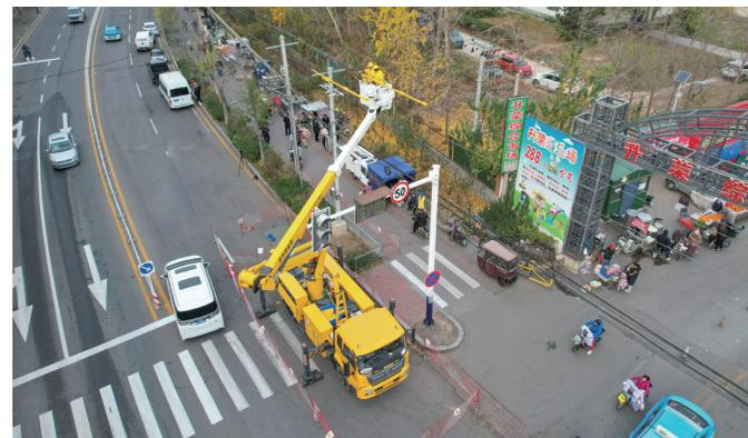
本报讯 “今天的工作是为润城水净化公司的双路电源进行增容服务，将容量扩增至1600千伏安。”近日，国网唐山供电公司两名身着黄色绝缘披肩的“小黄人”手持作业工具，顶着寒风在路北区河沿庄10千伏赵工线12+1号杆带电连接变压器开关上引线，在企业与客户用电“零感知”的情况下，顺利完成送电任务，保障广大客户用水用电安全。
